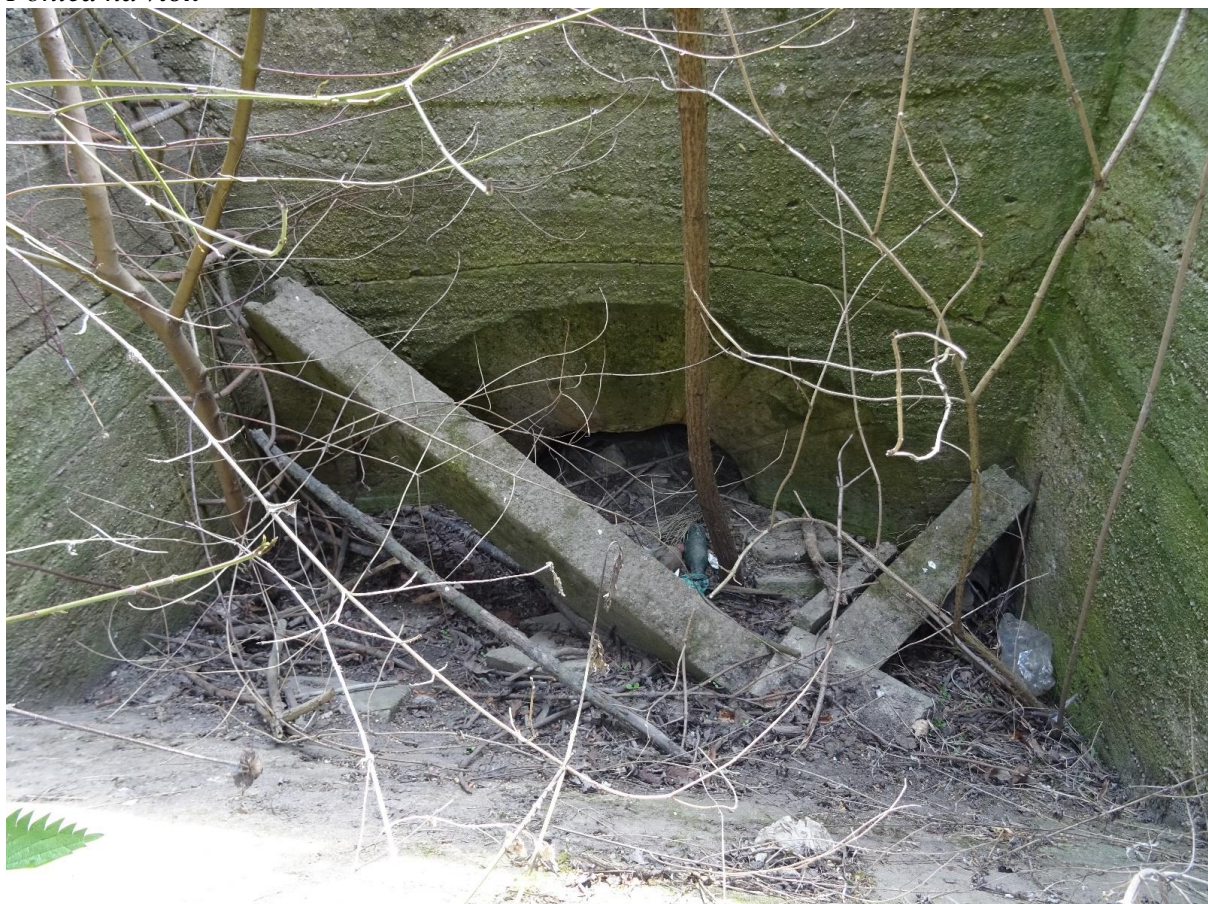
Pohled na zanesený vtok , kde je viditelná horní část propustku/ shybky
