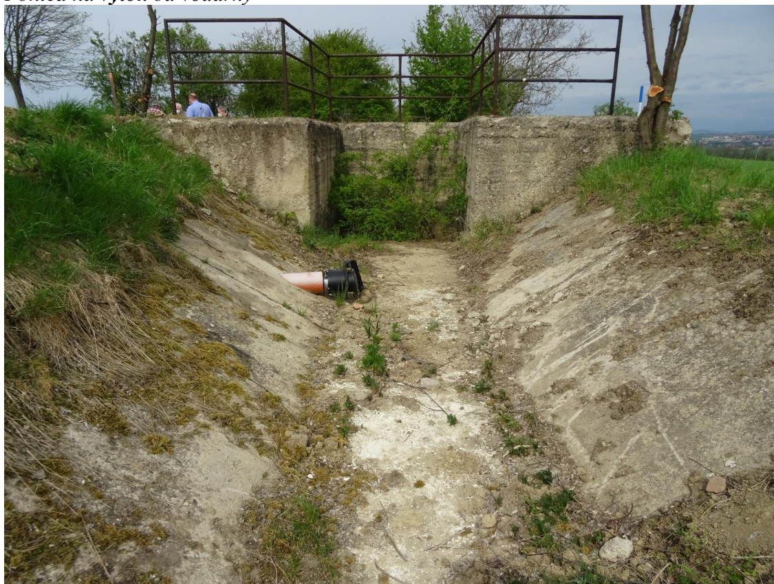
Pohled na výtok z kanálu. Pohled na bezpečnostní přeliv
