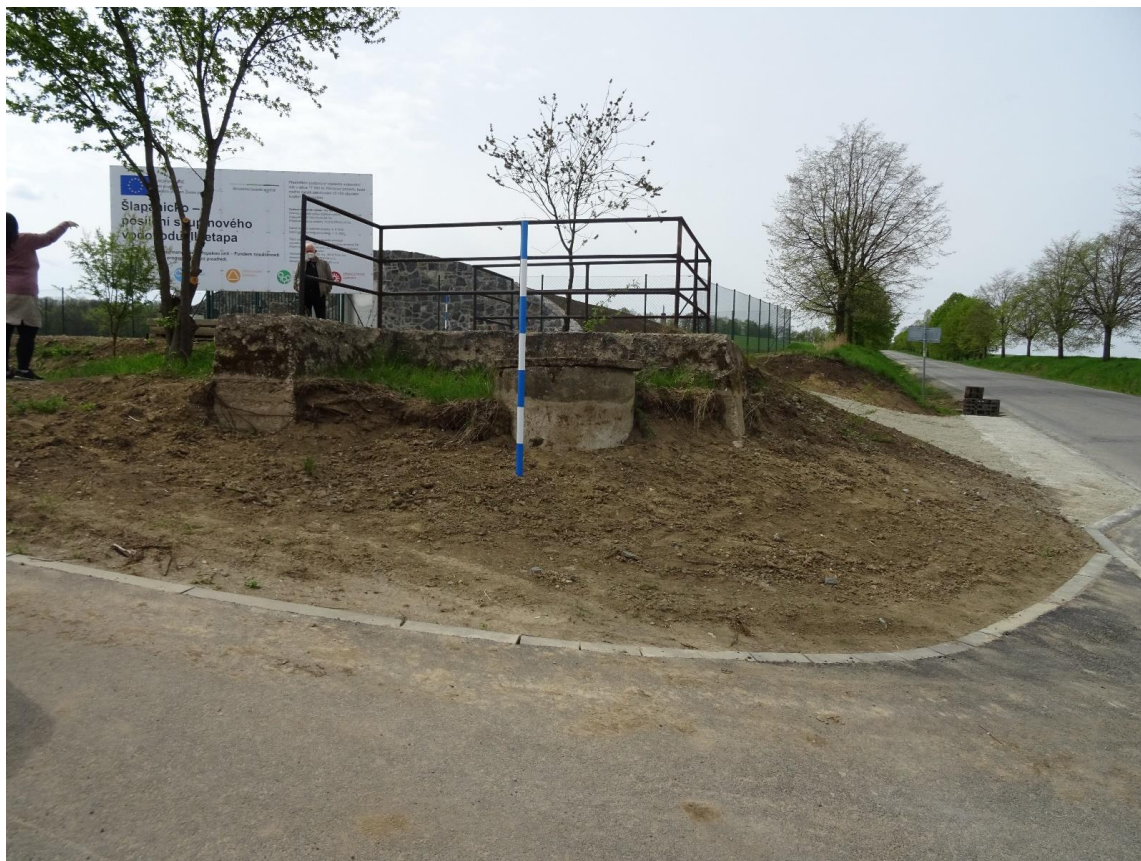
Pohled na výtok se sjezdu na polní cestu vlevo směrem k Mohyle míru. Betonová šachta meliorace
